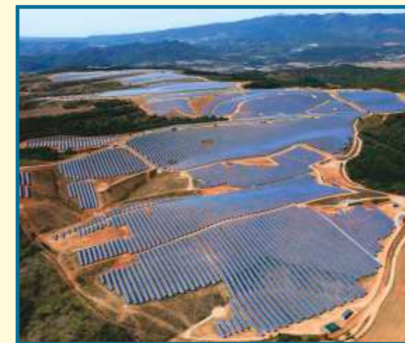
Les Mées, France (31 MWp)
